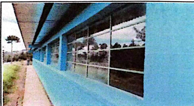
Foto 3: Sustrucción de vidrios
