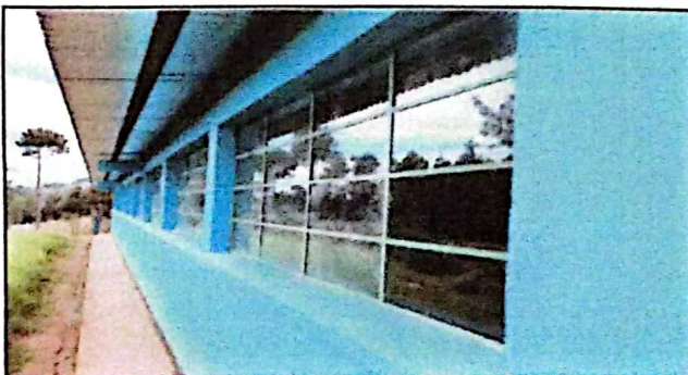
Foto 4: Sustrucción de ventanas
