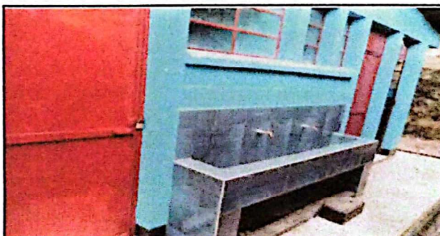
Foto 6: Reparación de lava manos
