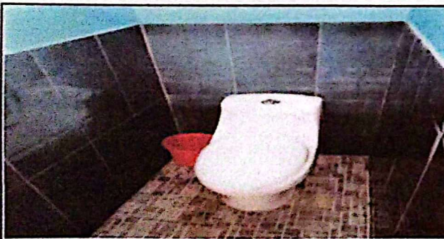
Foto 5: Instalación de sanitarios
