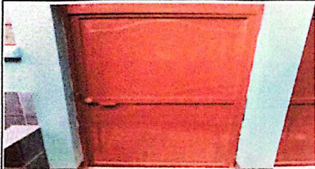
Foto 1: Sustrucción de puerta
